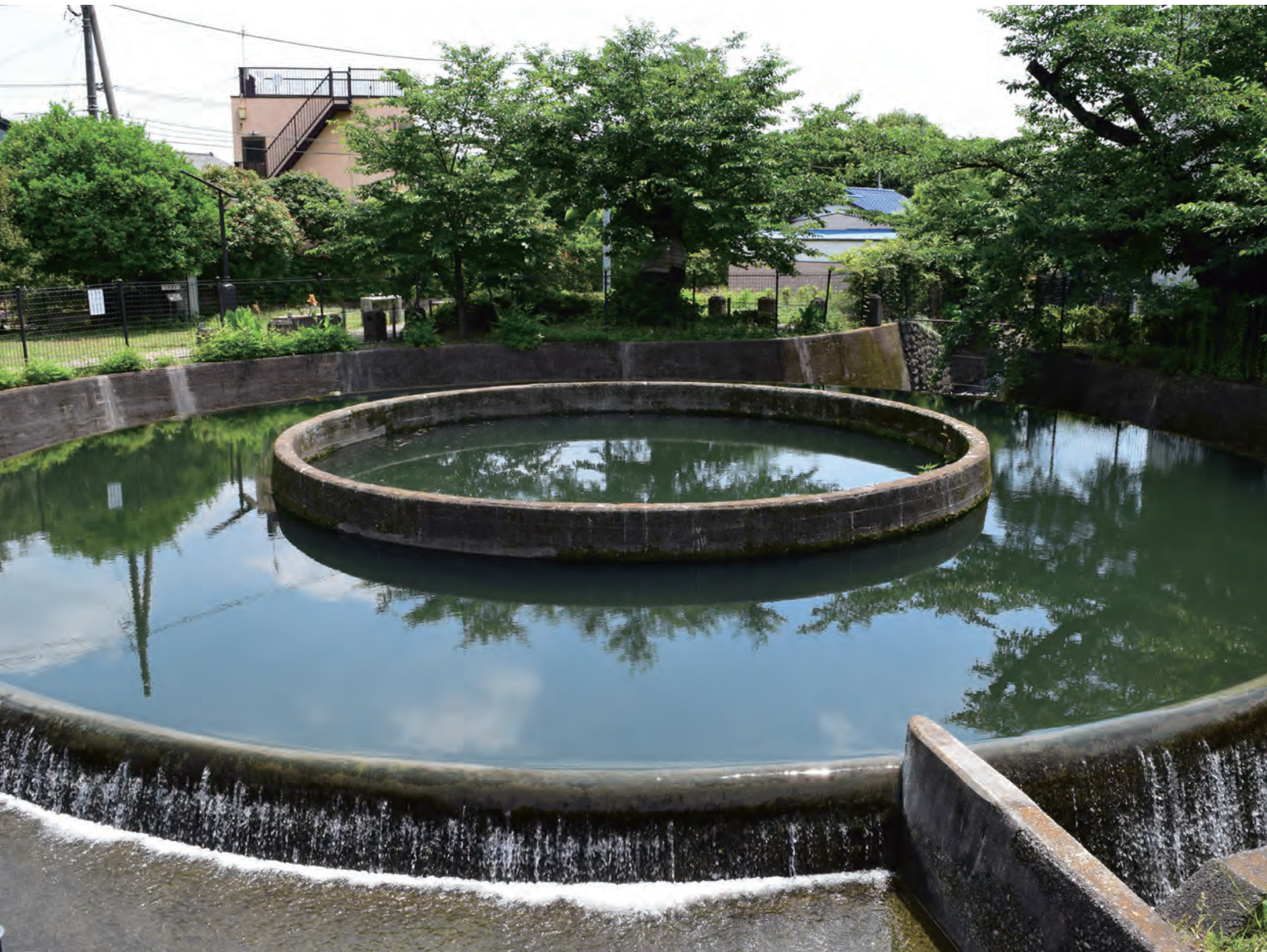
高津区 二ヶ領用水久地円筒分水
