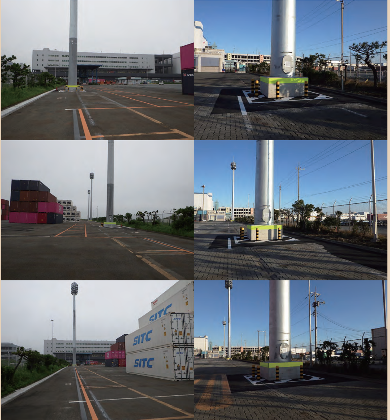
工事名称 川崎港コンテナターミナル照明鉄塔基礎新設その他工事 工事場所 川崎市川崎区東扇島92番地 工事概要 照明鉄塔基礎新設(6か所[各20㎡]) 屋外高圧受変電設備基礎新設(2か所[8.4㎡・7.7㎡]) 屋外附帯(舗装撤去復旧、メッシュフェンス) 発注者 川崎市まちづくり局 工期 平成30年7月17日～令和2年3月13日 施工 株式会社 横山工務店 ☆平成4、30、令和2年度 川崎市優良事業者表彰 被表彰者
